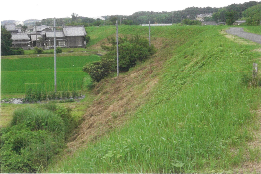
堤防法面 作業:機械+人力 法長:16m 勾配:1割
