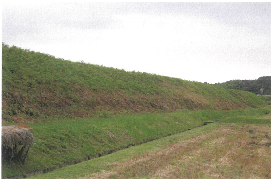
堤防法面 作業:機械+人力 法長:10m 勾配:0.5割
