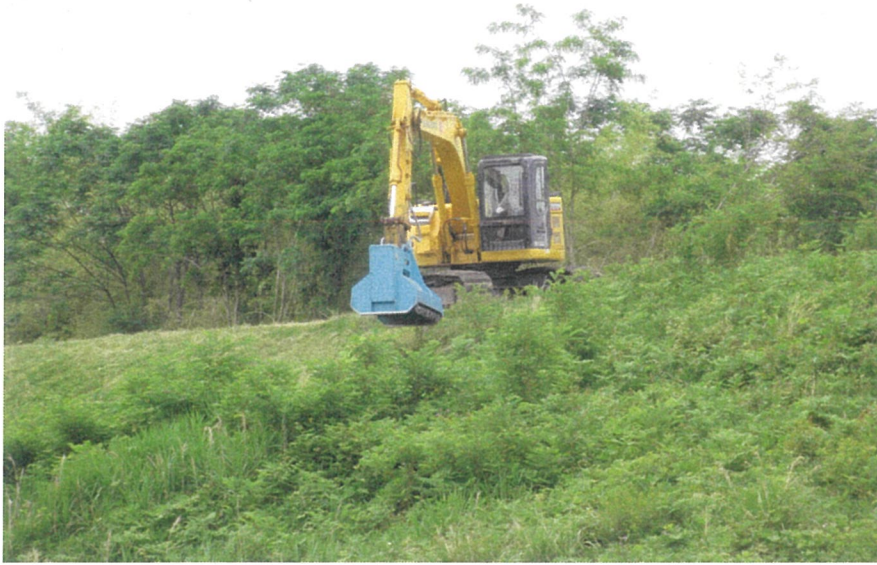
堤防法面 作業:機械+人力 法長:22m 勾配:1.0割
